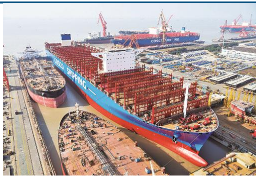
图7：21237TEU 超大型集装箱船建造期间
