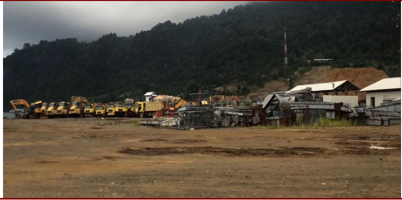
图 3：恒顺众昇印尼苏拉威西镍铁工业园建设工地
