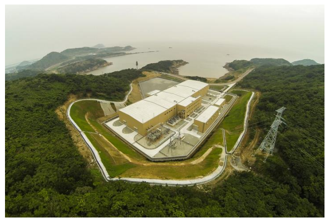
图 90：舟山 5 端柔性直流输电工程-岱山换流站外景
