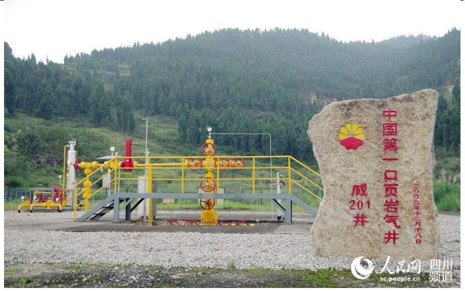
图 93：中国第一口页岩气井威 201 位于长宁-威远页岩气区
