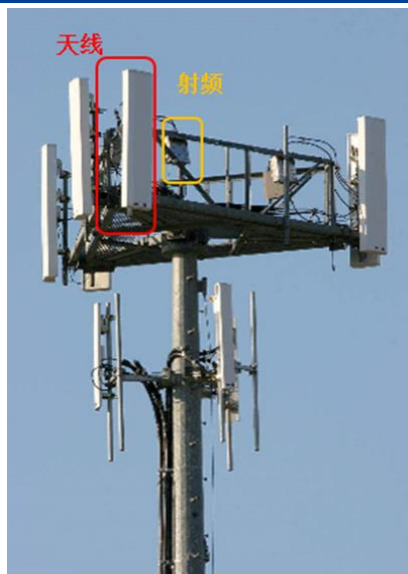
图表 3: 传统天线系统和基站射频系统分离
