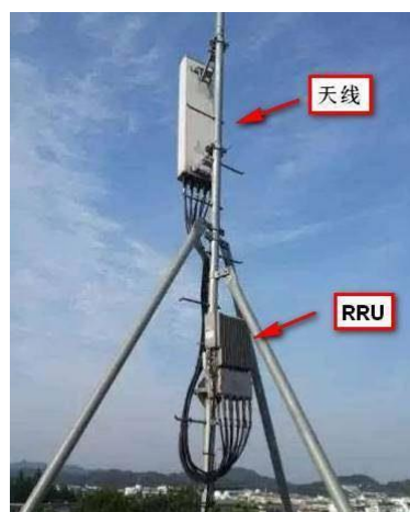
图 51：4G 时代天线和 RRU 分离，通过馈线链接
