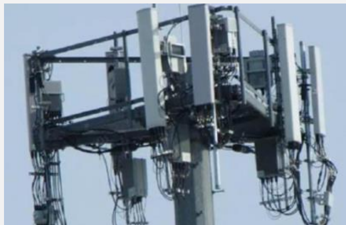
图：4G宏基站的天馈线盘根错节，不利于部署和维护
