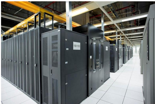
图 27：光环新网亦庄数据中心
