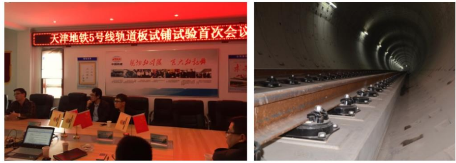
图 15: 公司地铁轨道板铺设天津地铁 5 号线试验段情况
