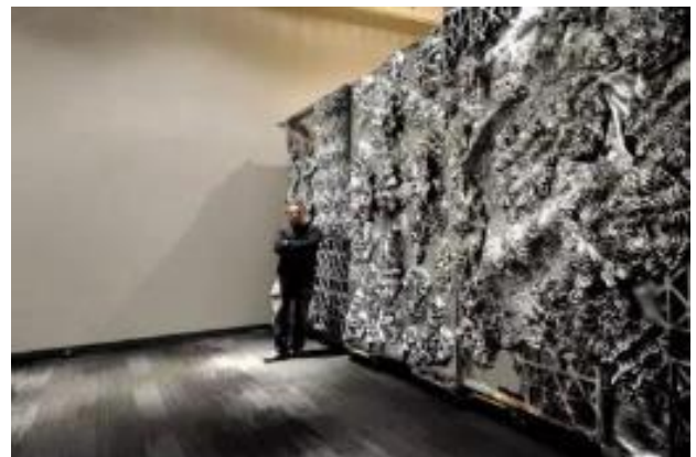
图表111 3D 打印出自由曲线墙壁
