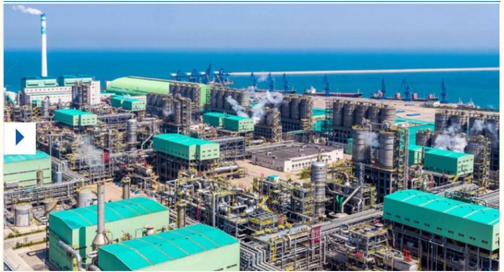
图表 50: 恒力石化大连长兴岛 PTA-1/2/3 装置
