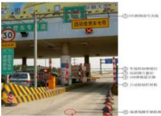
图表51： 高速公路电子不停车收费系统示意图
