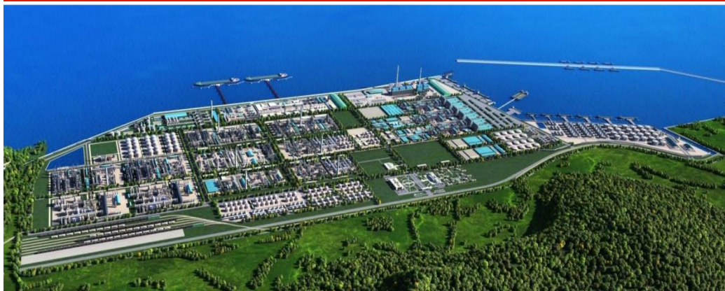
图表8：恒力石化炼化-乙烯-PTA 一体化项目
