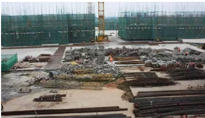
传统现浇工地较为混乱
