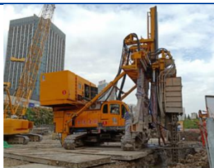
武汉中心书城项目基坑支护工程
