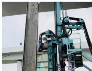
杭州市之浦路提升改造工程
