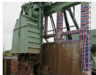
九江八里湖新区地下综合管廊...
