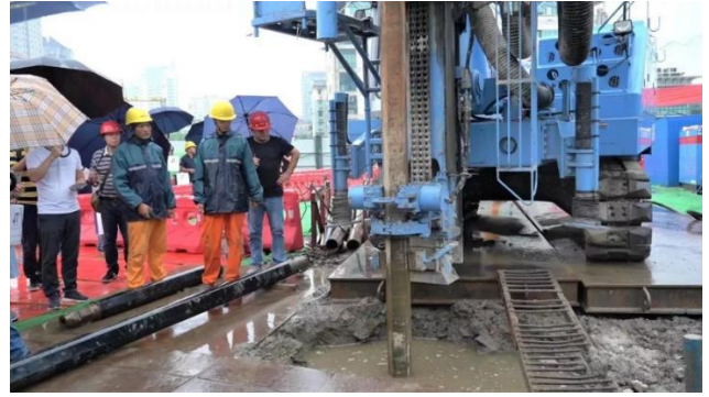
图表 41: 吉通地空建筑 IMS 工法施工图
