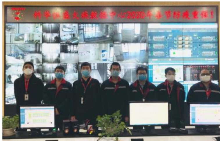
图 131：数据中心运维非人力密集型
