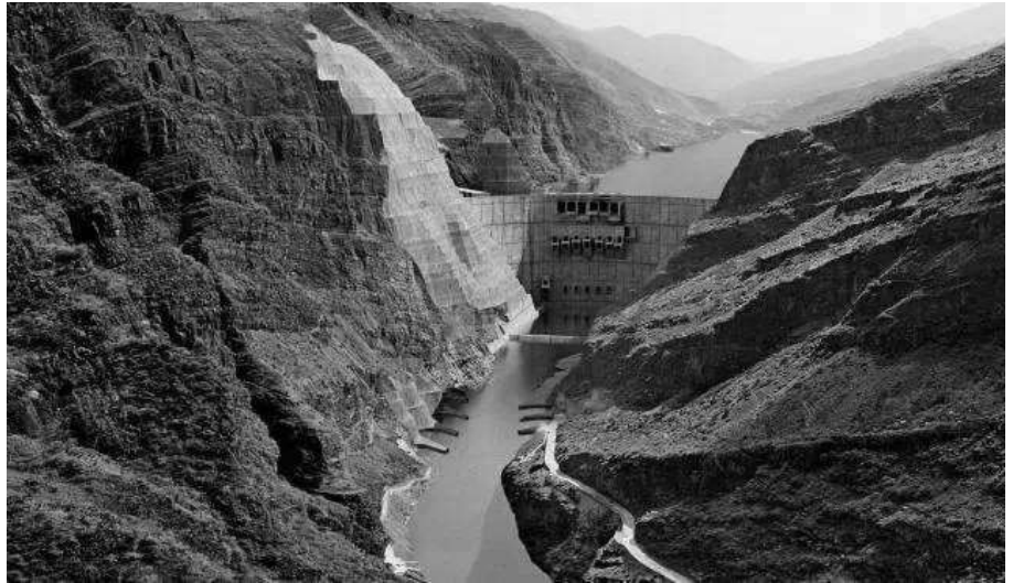
图 3: 三峡集团白鹤滩工程建成后是仅次于三峡水电站的我国第二大水电站
