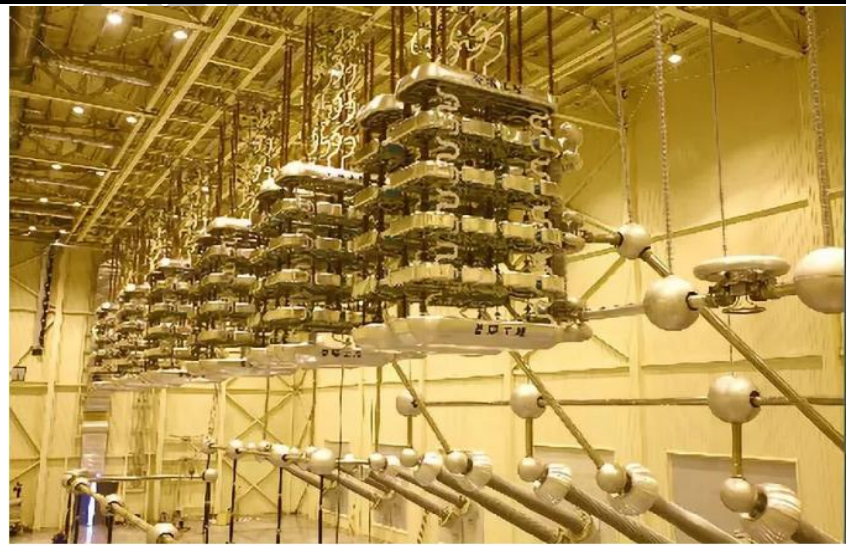
图表21：锦屏—苏南工程中运行的±800kV/5000A换流阀
