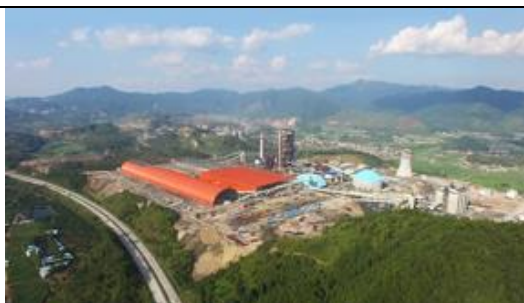
图 18: 塔牌集团文福万吨生产线项目
