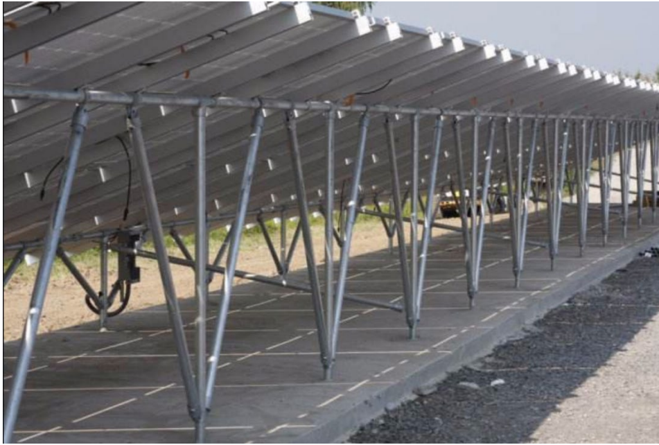
图 12： 光伏支架边框以铝合金材料为主
