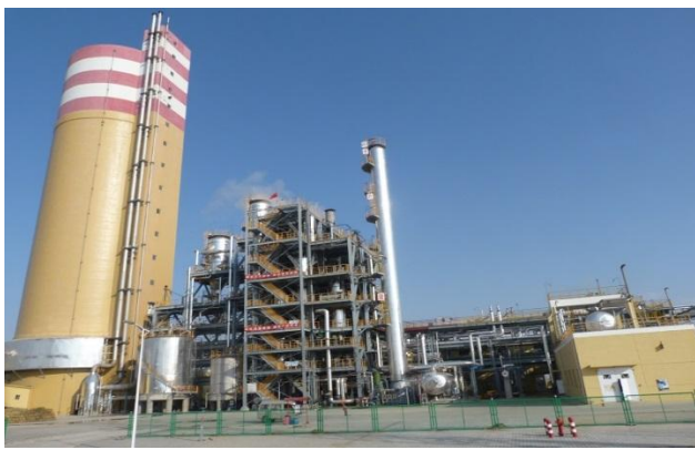
图表34： 鄂尔多斯市亿鼎煤化工工程
