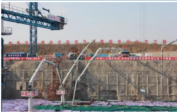
图表21： 石湾岛高温气冷堆工程开工
