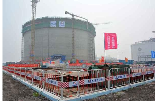
图表35： 天津 LNG 替代工程 16 万方储罐项目
