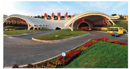
翔安隧道: 世界最大断面钻爆法海底隧道
