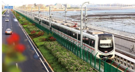
厦门轨交一号线: 国内最美海景地铁
