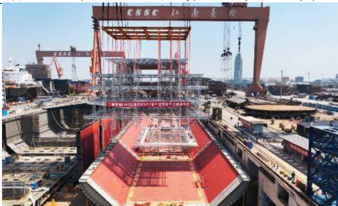
图表83: 江南造船厂 LNG 船液货舱首舱平台模块吊装
