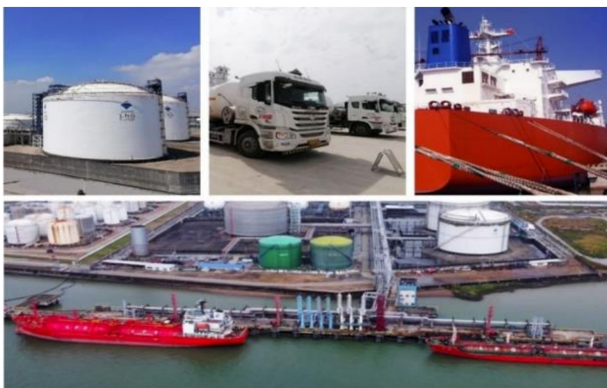
图26：公司 LNG 船舶、接收站、储罐及槽车等能源物流相关核心资产
