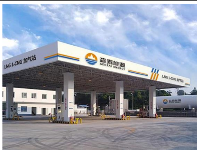
图35：森泰能源的LNG/L-CNG加气站
