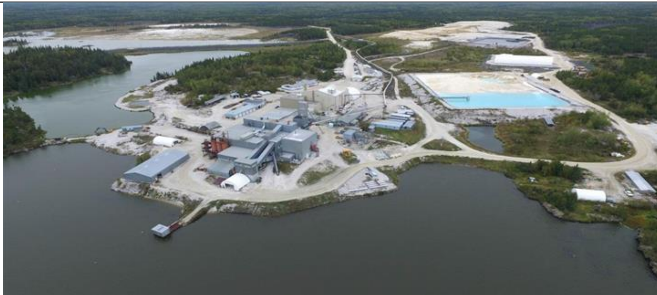
图18: Tanco 矿山现场生产设施情况
