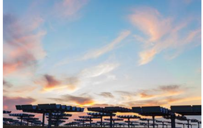
图21: 汉能禹城 40MW 光伏电站项目
