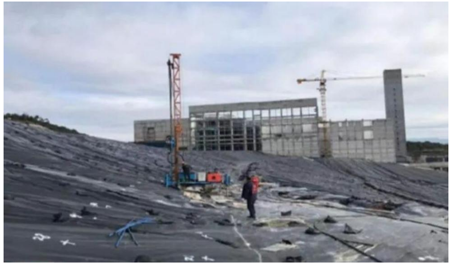
图表 10: 广州市第七资源热力电厂存量垃圾开挖
