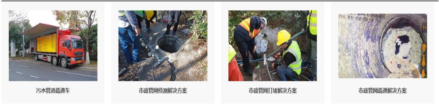
图7：公司利用超高压水切割技术开展城市地下管网综合治理服务
