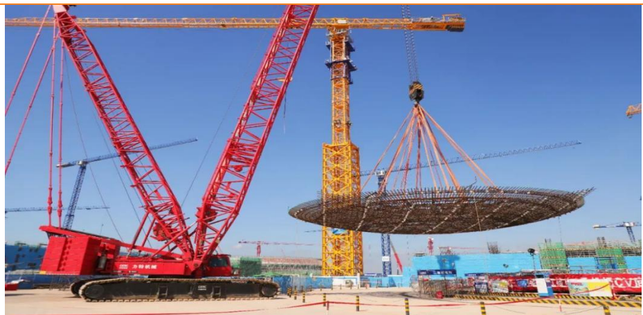
图 4：AP 堆模块化施工现场
