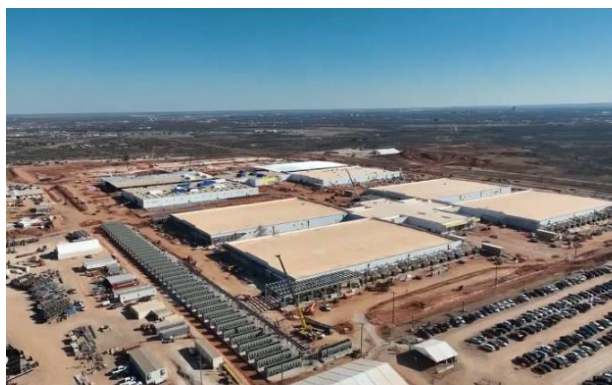
图9：星际之门一号站建设现场图
