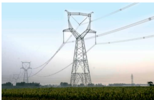
图 1：1000 千伏晋东南特高压示范工程铁塔
