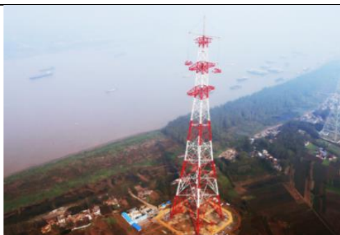
图 2：1000 千伏淮上线长江大跨越铁塔
