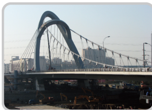
缆索用于常州龙城大桥
