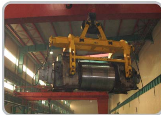
济南钢铁热轧厂 70 吨轧辊吊装
