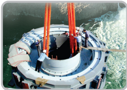
三峡工程 415 吨机组转子吊装
