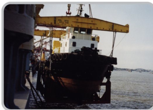
海洋特制梁式吊具吊装
