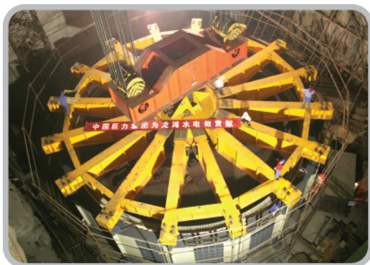
广西龙滩水电站 900 吨梁式吊具吊装
