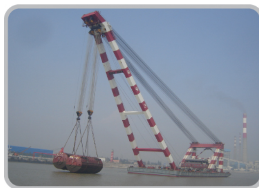
“华夏第一绳”华天龙号吊装
