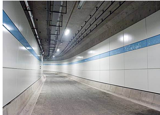
北京奥林匹克公园地下联系通道
