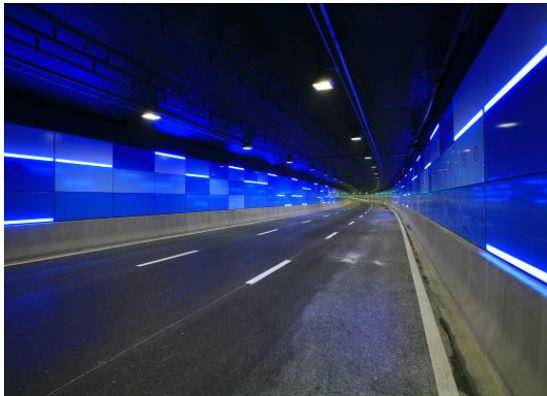
上海外滩隧道
