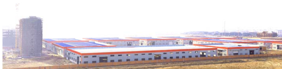
2014年2月木材加工企业建设实拍现场图-1
