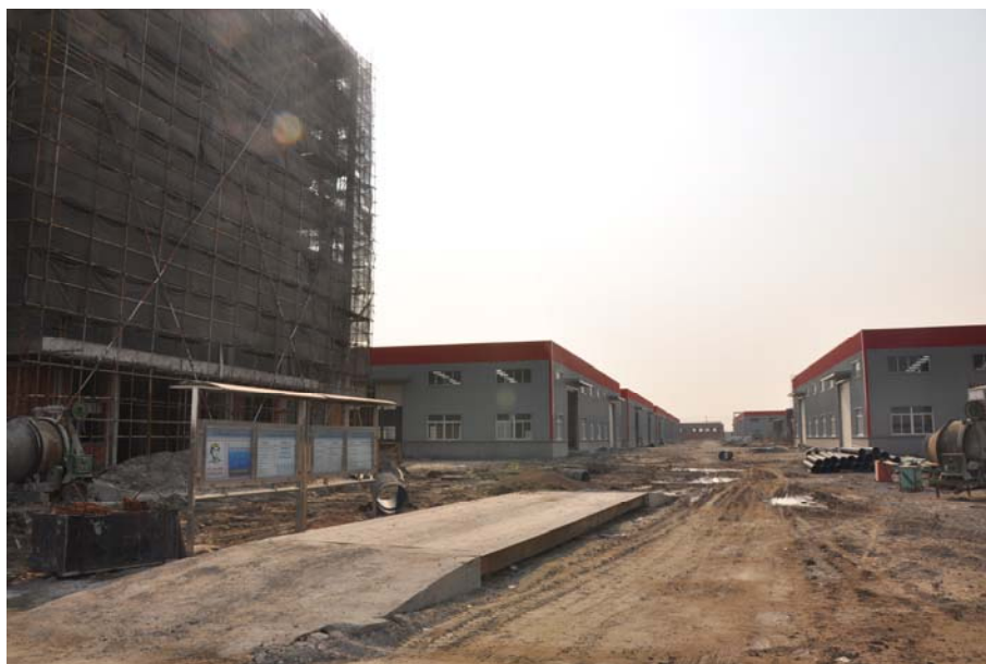
2014年2月木材加工企业建设实拍现场图-3
