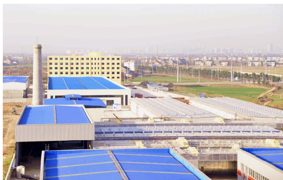
2014年2月木材加工企业建设实拍现场图-2
