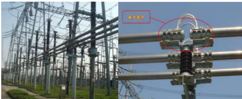
图：公司电力金具产品贵州都匀 500kV 福泉变电站融冰样板工程投运现场
