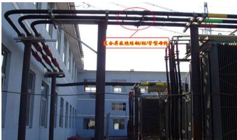
图：公司复合屏蔽绝缘管母产品辽宁本溪北台钢厂 220kV 变电站投运现场
