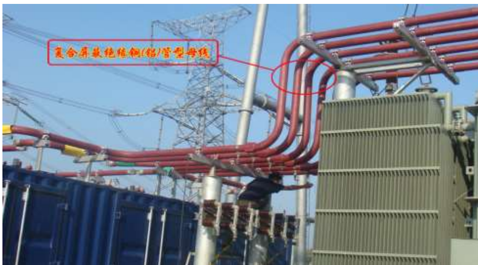
图：公司复合屏蔽绝缘管母产品辽宁本溪北台钢厂 220kV 变电站投运现场
