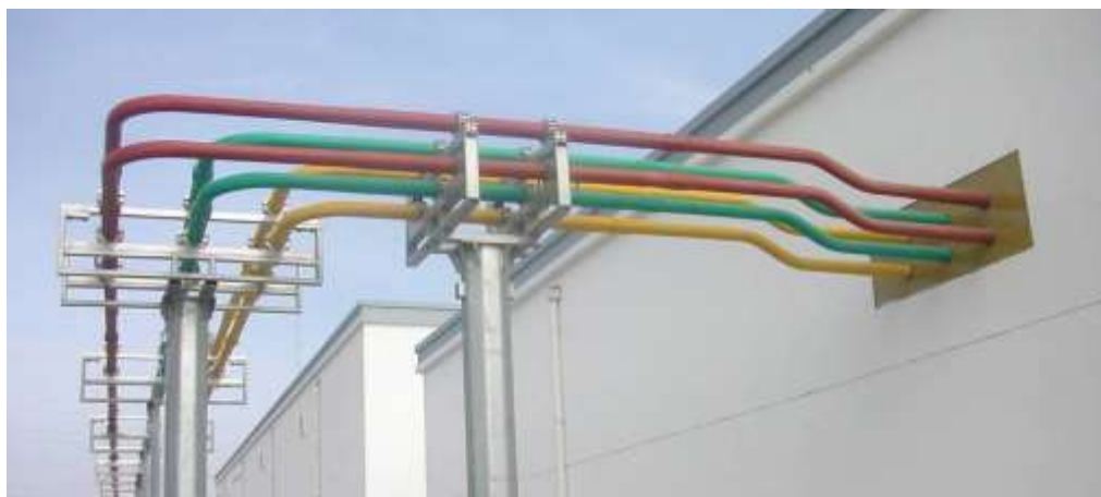
图：复合屏蔽绝缘管母线
