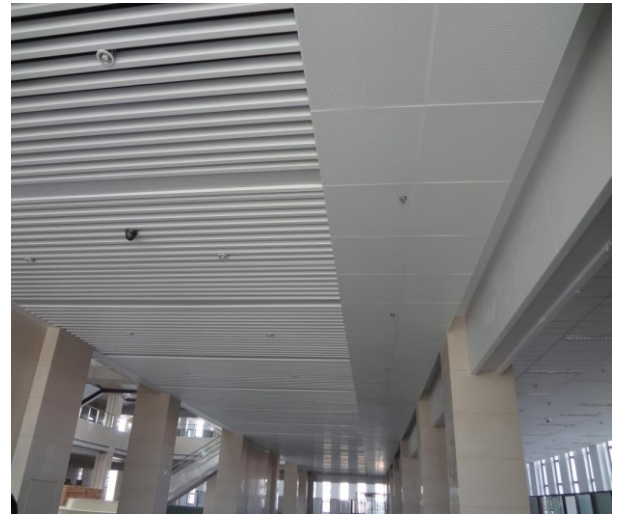
政务中心喷淋报警消防系统
