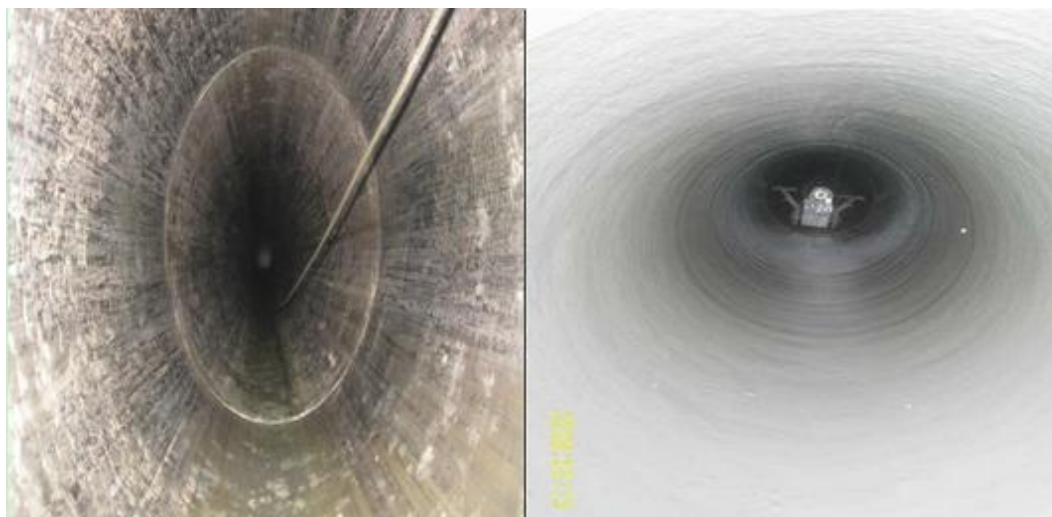
喷涂修复前、除锈后、喷涂后管道内壁对比
