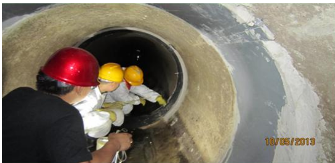
管道局部修复现场
