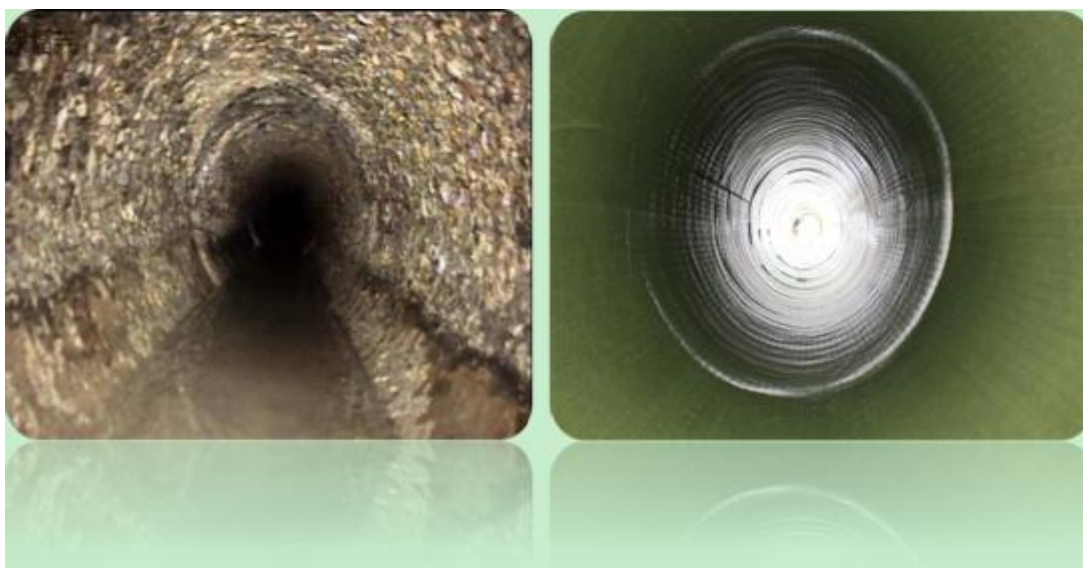
UV-CIPP 修复前后管道内壁对比
