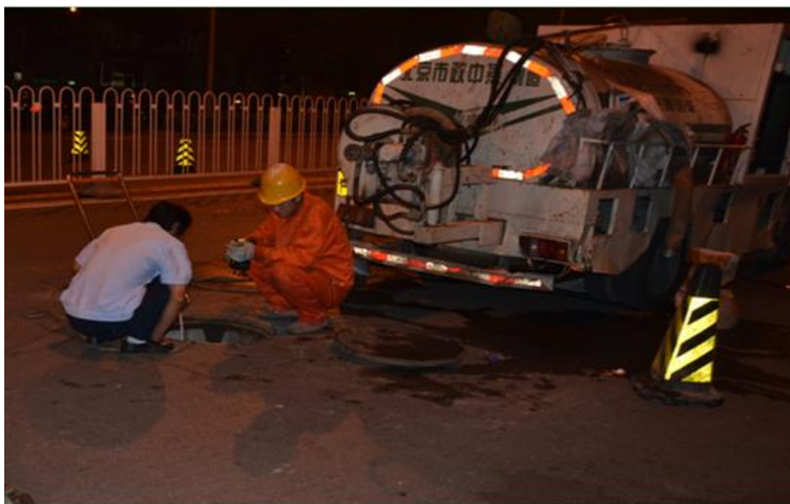
管道疏通现场
