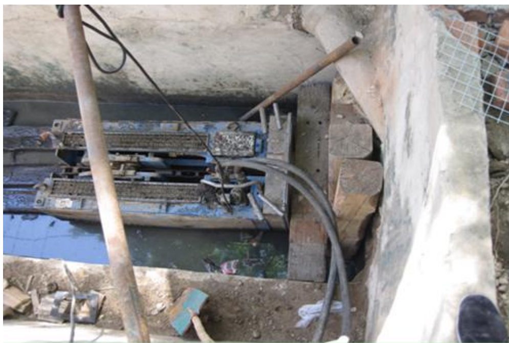
裂管修复施工现场
