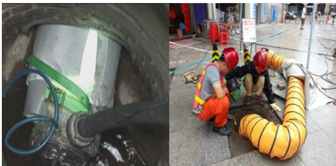
UV-CIPP 施工现场
