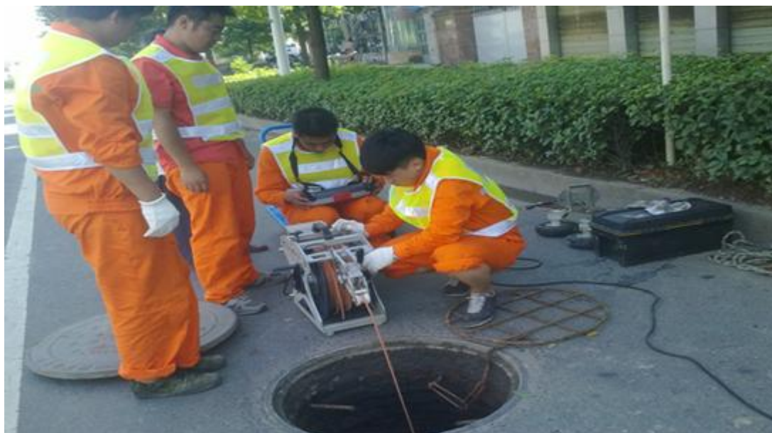
管道视频检测机器人作业现场
