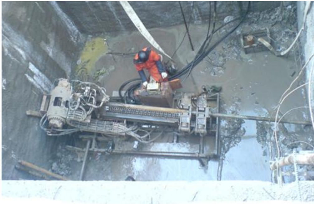
坑内始发水平定向钻进铺管现场
