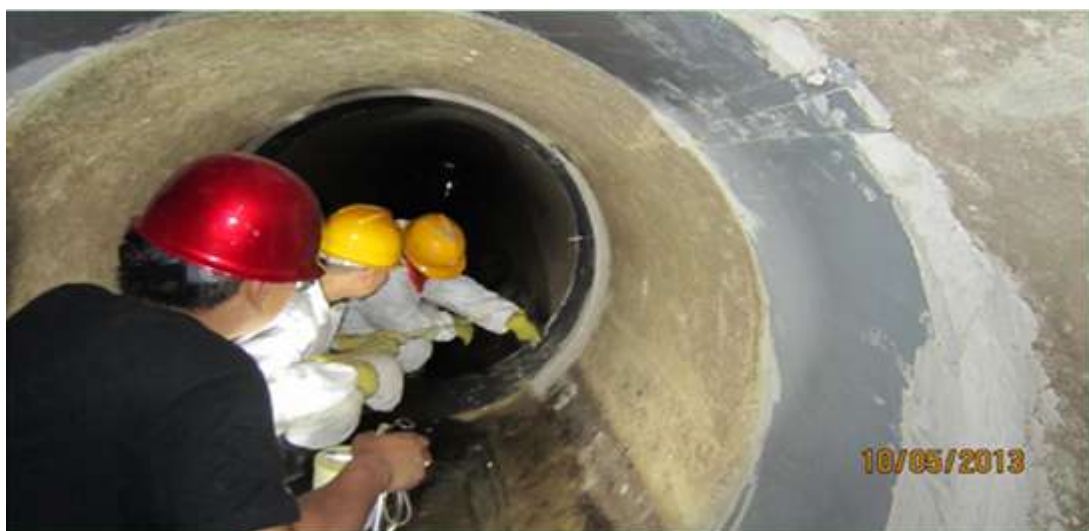
管道局部修复现场
