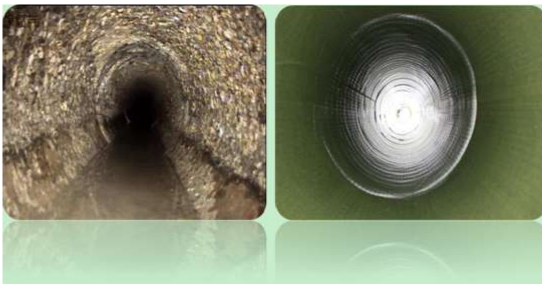
UV-CIPP 修复前后管道内壁对比
