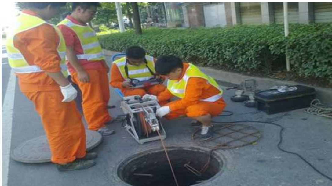
管道视频检测机器人作业现场
