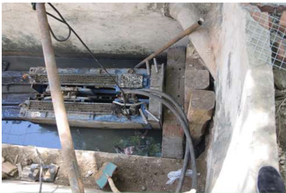
裂管修复施工现场
