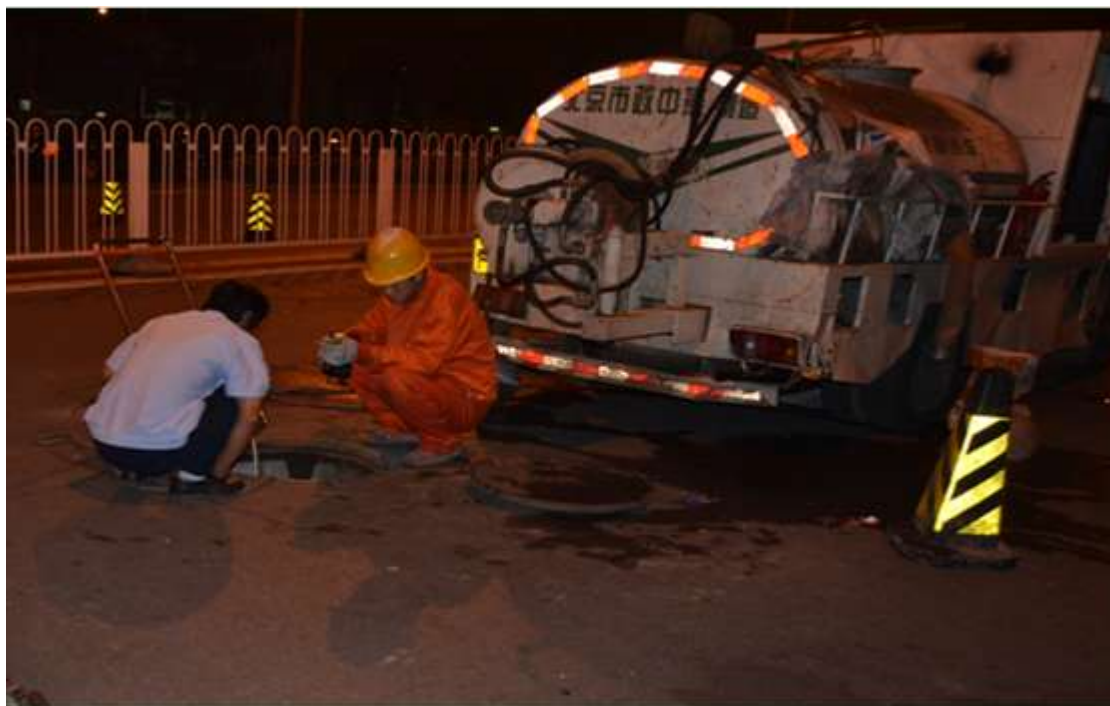
管道疏通现场
