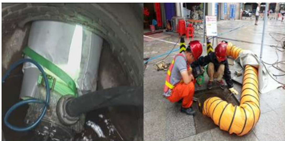
UV-CIPP 施工现场
