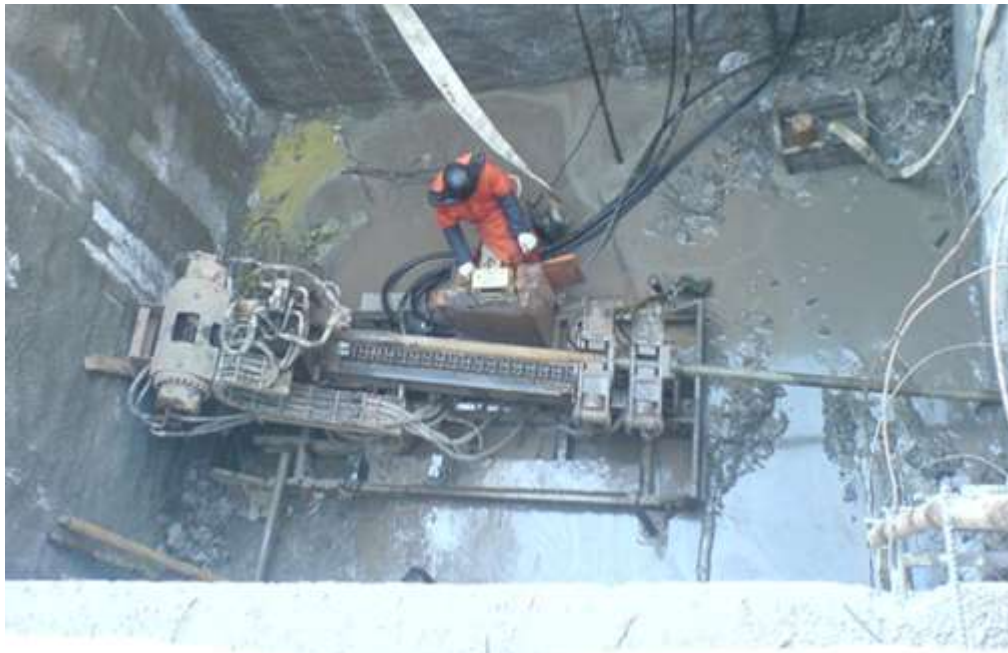
坑内始发水平定向钻进铺管现场
