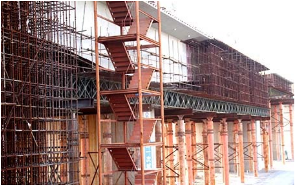
贝雷类支护设备的拼接过程如下图所示：
