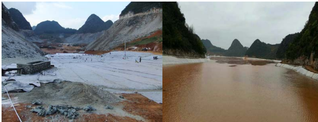
图：尾矿库防渗工程
