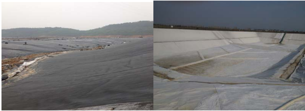
图：垃圾填埋防渗工程
