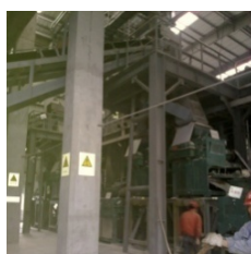
水泥缓凝剂生产线
