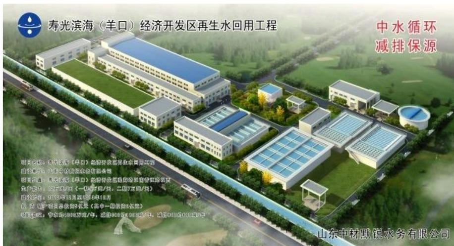
2) 山东寿光滨海（羊口）经济开发区再生水管道东延 BT 项目，项目情况：采用钢丝网骨架 PE 管直埋施工、跨路与跨河顶管施工、管网及泵站土建项目施工。
