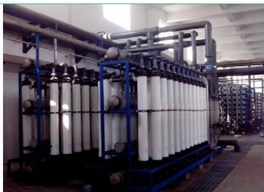
神华宁煤集团金凤煤矿井下水处理站工程现场图一“一种用于煤矿矿井水的双膜处理系统”
