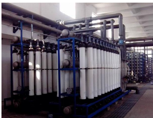
神华宁煤集团金凤煤矿井下水处理站工程现场图一“一种用于煤矿矿井水的双膜处理系统”
