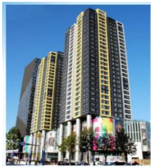
太原新领小区污水源热泵项目
