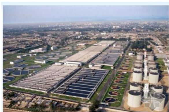
北京大兴黄村污水处理厂项目
