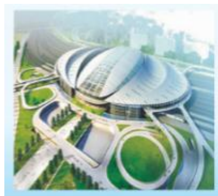
北京南站污水源热泵空调项目
