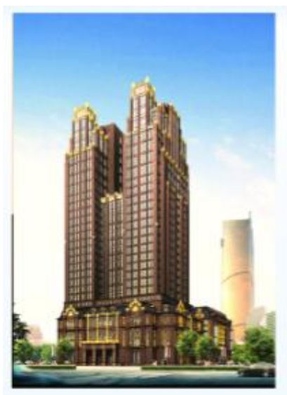
天津公馆污水源热泵项目
