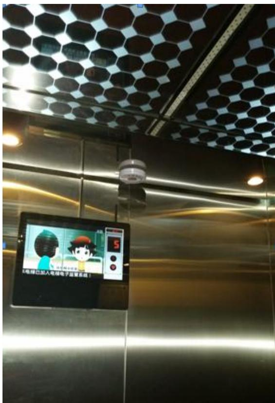
安装在电梯轿厢的视频终端能够显示电梯运行和视频信息。视频终端左侧主画面显示视频信息，视频终端右侧显示电梯运行楼层信息、电梯运行方向信息、电梯故障信息、电梯维保信息，显示屏底部为滚动文字信息。当电梯处于维保状态时，视频终端主画面显示电梯维保信息；当电梯处于故障状态时，视频终端主画面播放乘坐电梯安全指导视频信息；当电梯正常运行时，视频终端主画面播放视频信息，视频信息可通过管理平台分时段、分区域实现精准推送。
