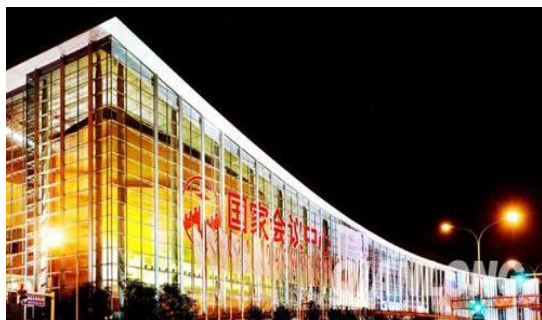
国家会议中心电力运维管理系统
