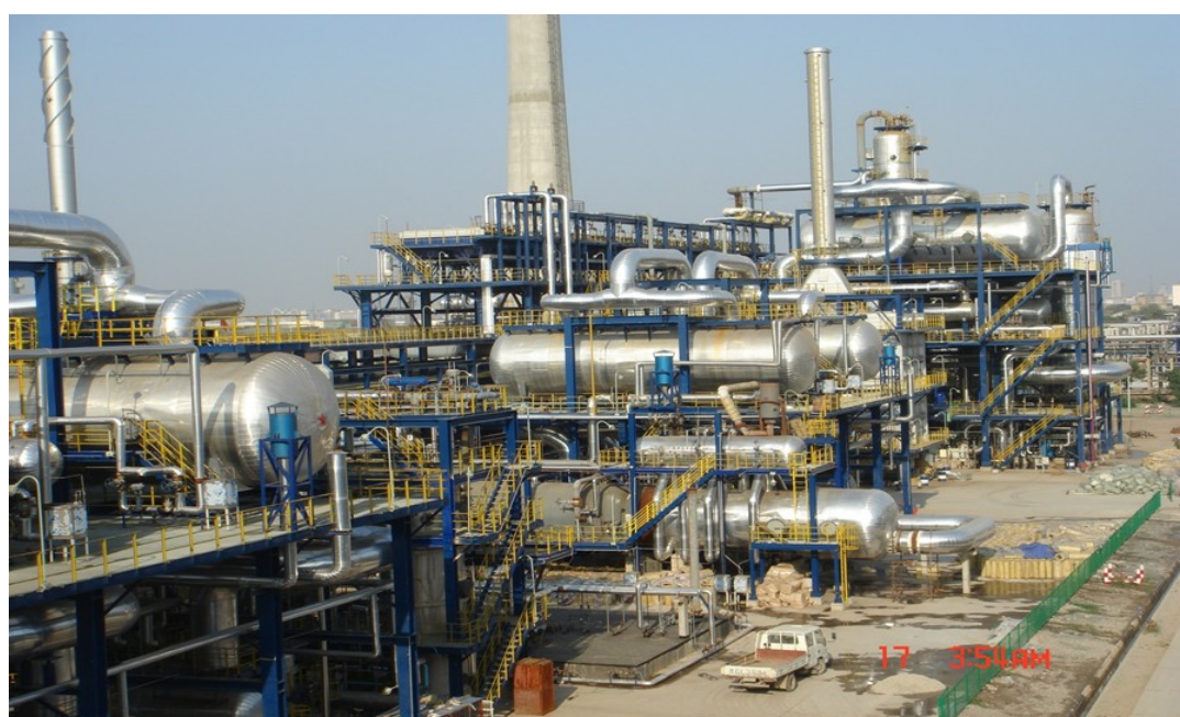
(天津石化 20 万吨/年硫磺回收装置)
