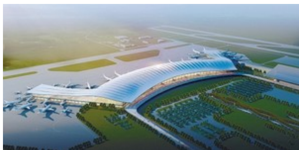
沈阳桃仙机场
