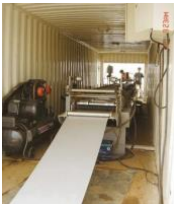
现场生产进料口
