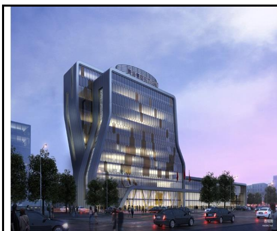
青海夏都医药公司综合办公楼
